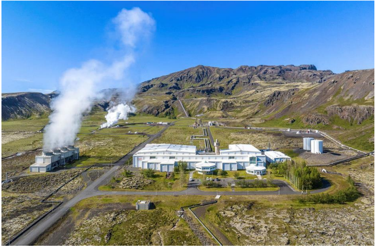
Mynd 3. Horft yfir Nesjavallasvæðið í suðvestur. Hengill í bakgrunni og stöðvarhús virkjunarinnar í forgrunni. Ljósmynd Einar Jónsson, Orkuveitan.
