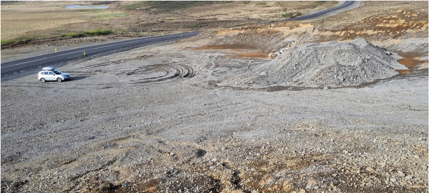
Mynd 38 E8 Kolgróf, Bíldsfelli. Horft í N ofan af barmi svæðis. Efnishaugur t.h. og opin efnistaka handan hans.
