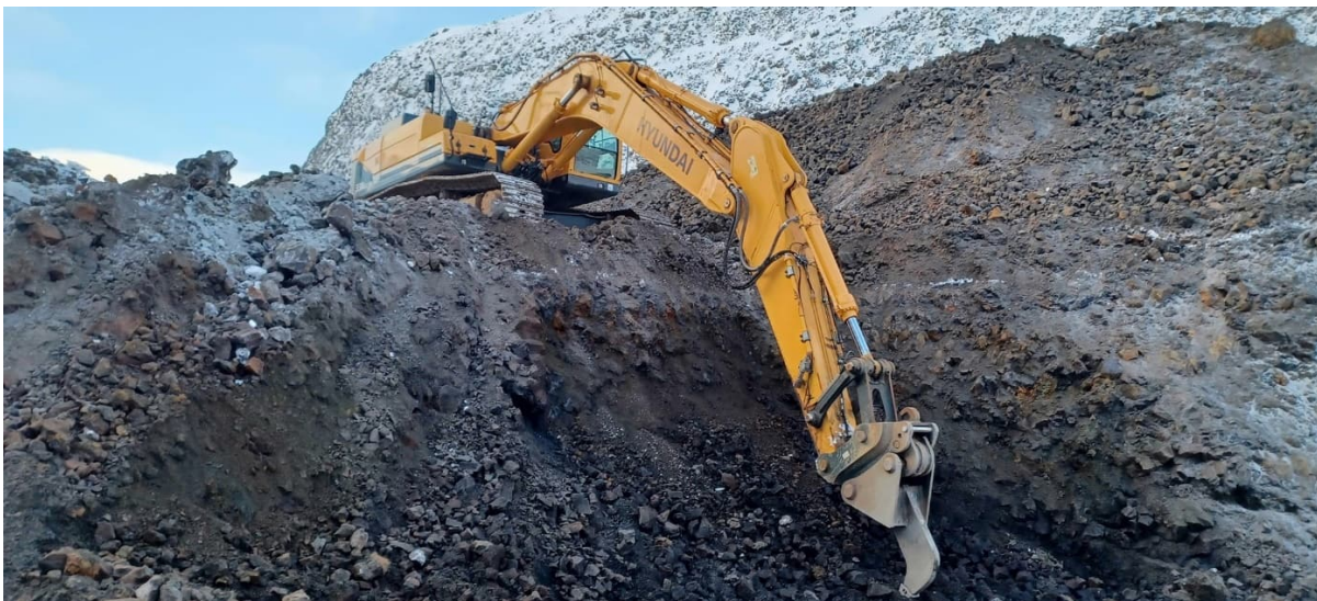
Mynd 2 E2 - Nesjavellir. Horft í SV. Grafa frá Ósk – Ási ehf. í febrúar 2022 að rífa upp bólstrabergið sem verktaki Orku náttúrunnar ehf. vegna framkvæmda á Nesjavöllum. ( https://www.facebook.com/oskasehf/photos/pcb.1337910893341976/1337910650008667 ).
