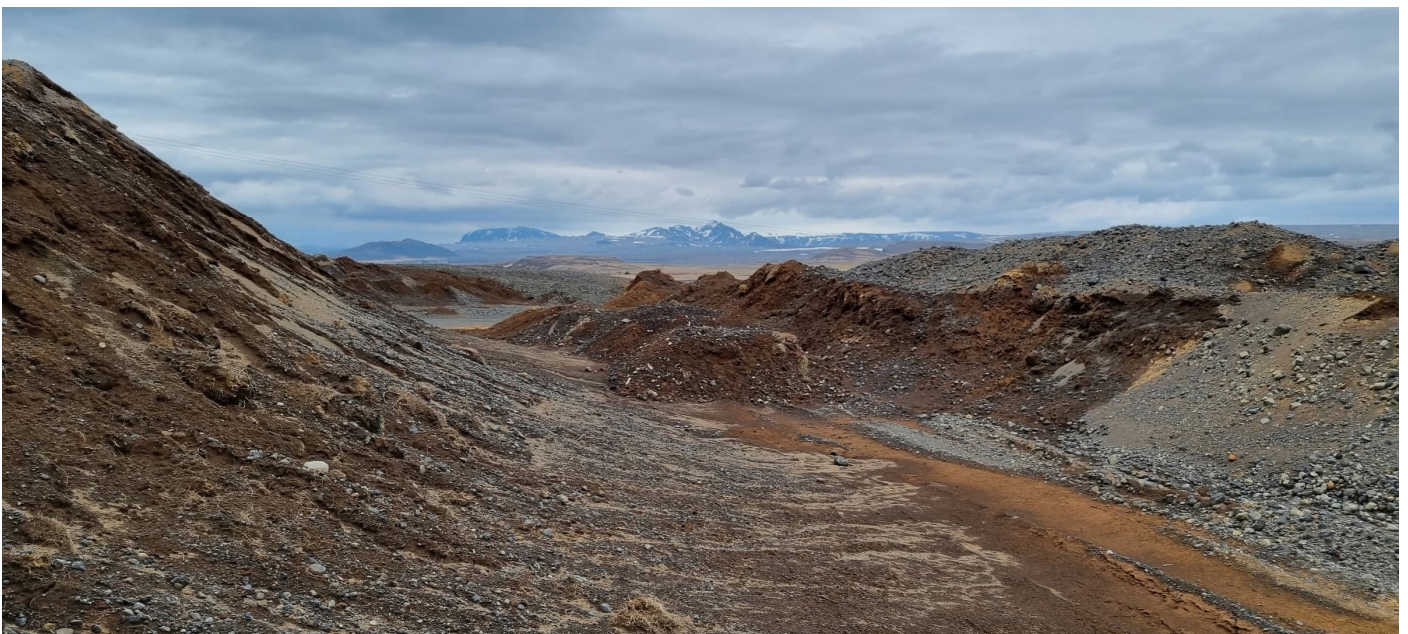
Mynd 12 E3 - Krókur efri. Horft í N. Efnislosun blandaðrar moldar á efri og síðar gerðum palli svæðisins.
