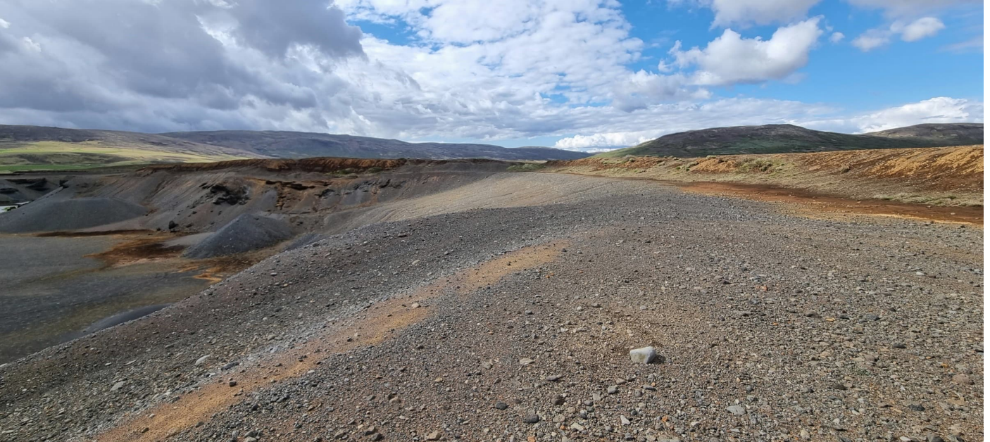
Mynd 50 E12 – Tunga, Bíldsfelli. Horft í NV. Búið að hreinsa þurrlandisjarðveginn af malarhjallanum á brúninni og mynda moldarmanir t.h. Stál með sendinni möl og hörðnuðum sandi, móhellulinsum, í bland. Tveir efnishaugar t.v. Hlíðarfjall í baksýn t.v. og Björk og Bíldsfell t.h.
