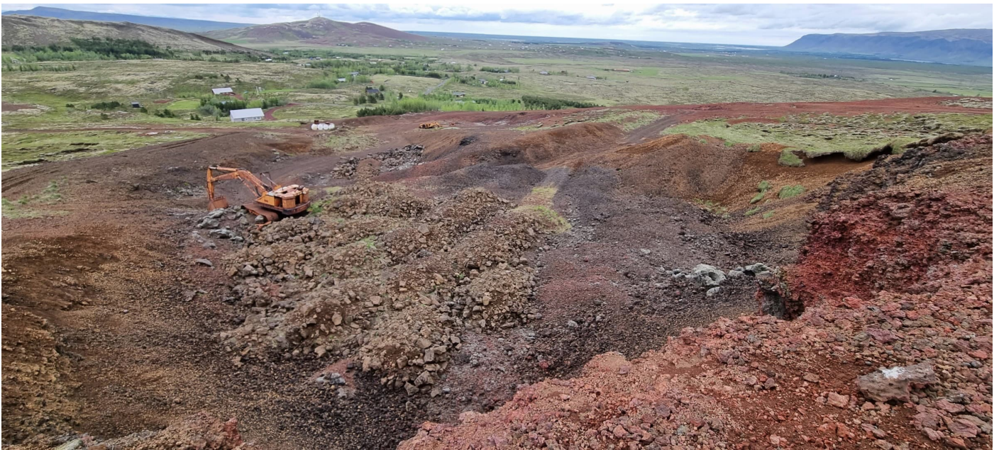
Mynd 69 Horft í S. Framhald af fyrri mynd. Efnislosun hraungrýtis í gryfjuna.
