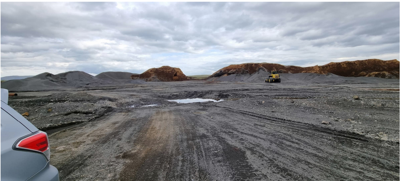
Mynd 107 Horft í S. Jarð- eða grunnvatn í forgrunni. Efnishaugar með unnu steinefni t.v. og t.h. Óunnið jarðefni aftan við t.h. með mold ofan á malarhjallanum. T.v. við miðju er einnig óunnið efni, frekar en moldarhaugur til seinni tíma frágangs svæðisins.
