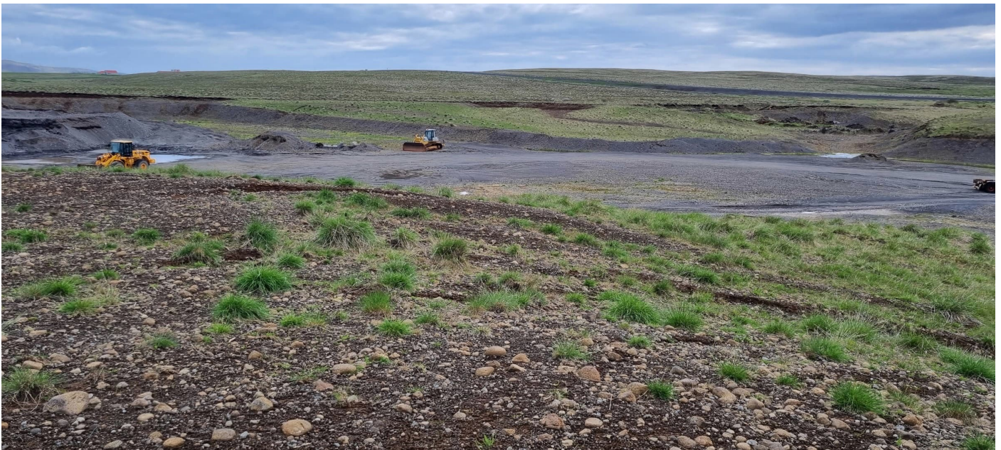
Mynd 77 Framhald af fyrri mynd, nú horft í SV yfir syðsta hluta efnistökusvæðisins, þar sem efnistöku er lokið og svæðið frágengið að stórum hluta.
