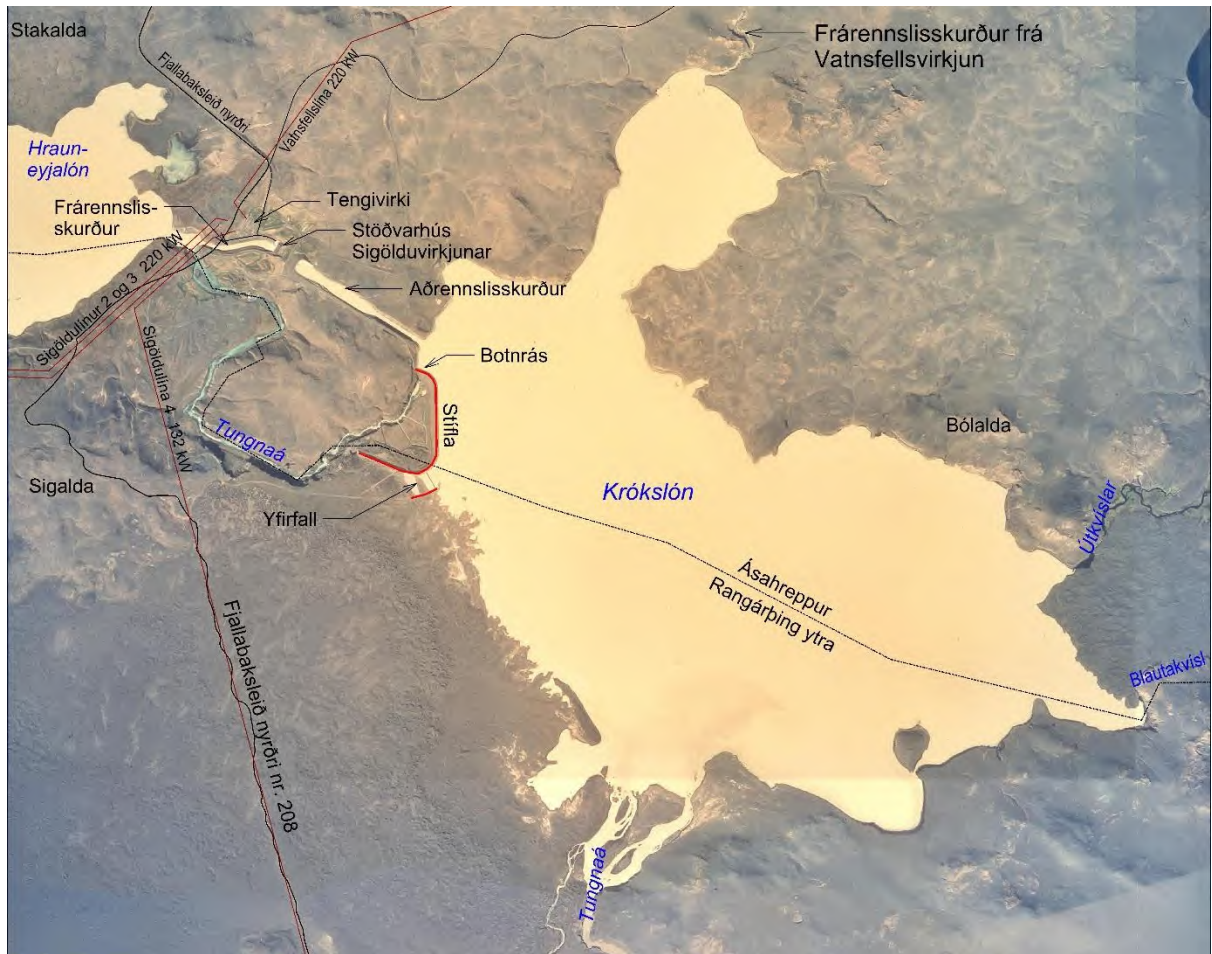
MYND 1. Mannvirki Sigöldustöðvar.
