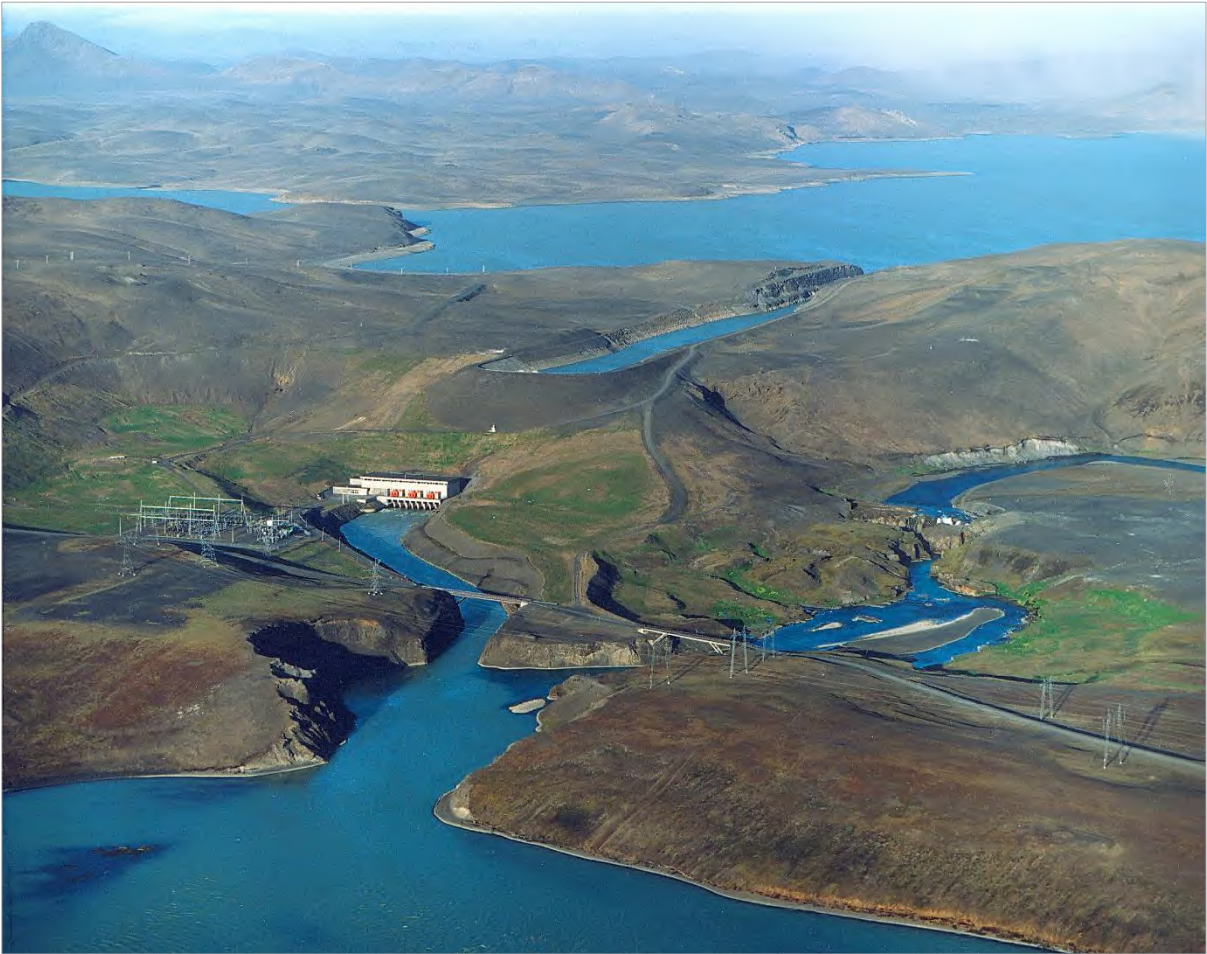
MYND 2. Sigöldustöð og tengivirki. Krókslón efst á myndinni og Hrauneyjalón neðst. Farvegur Tungnaár til hægrí. (Mynd: Emil Þór Sigurðsson).
