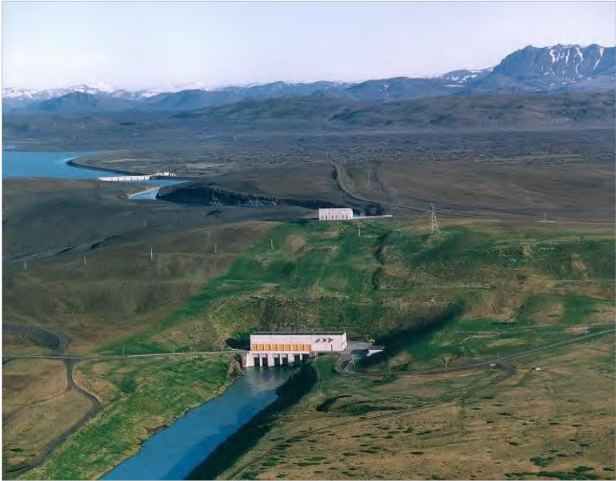
MYND 2. Stöðvarhús, inntak og frárennisskurður Hrauneyjafossstöðvar, sér í Hrauneyjalón ofar. (Mynd: Emil Þór Sigurðsson).
