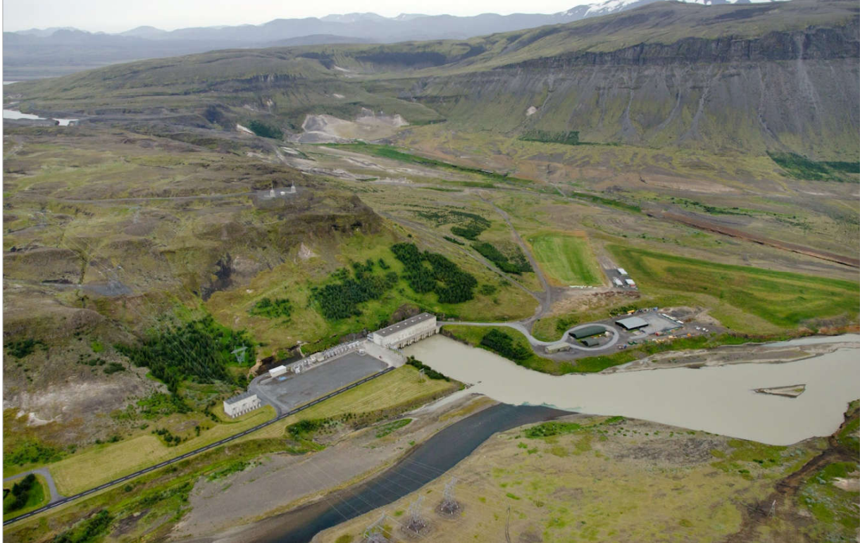
Séð yfir stöðvarhús og tengivirki Búrfellsvirkjunar og framkvæmdasvæði Búrfellstöðvar II. Mynd: Emil Þór Sigurðsson.
