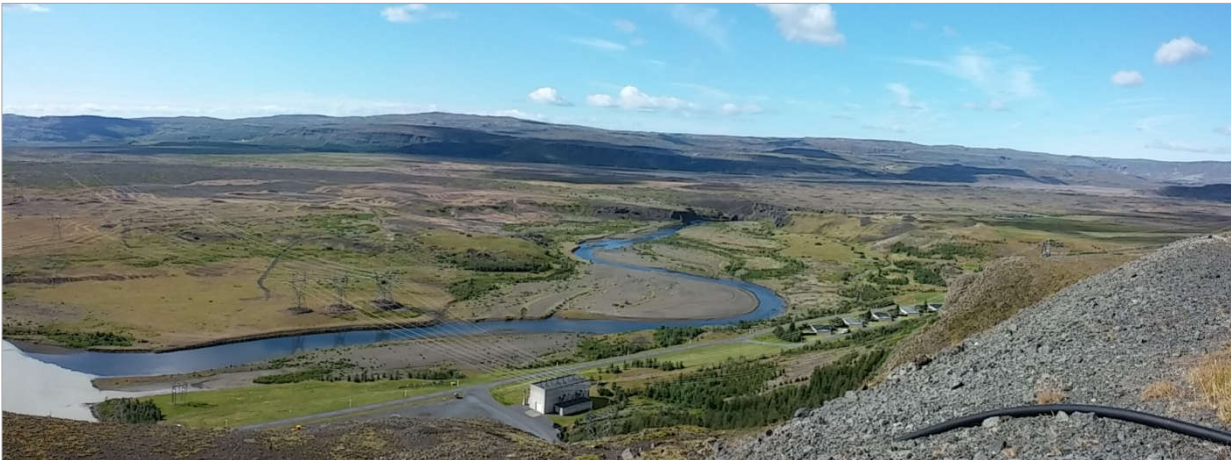
Horft norður yfir tengivirki og syðsta hluta starfsmannaíbúða.
