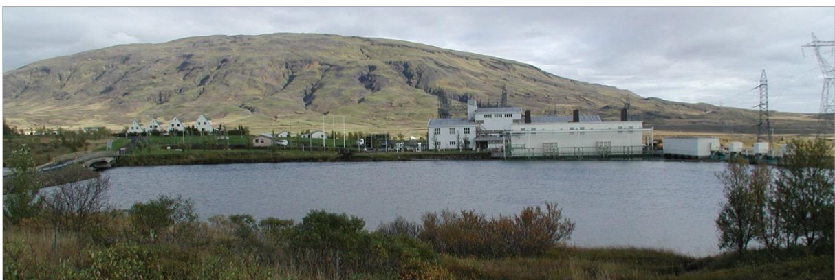
MYND 2. Írafossstöð og mannvirki tengd henni. Búrfell í baksýn. Mynd: Landsvirkjun.
