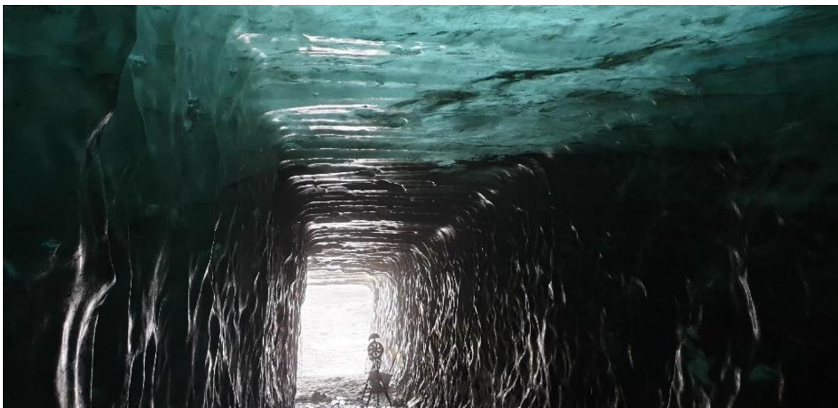
MYND 2. Áferð á íshelli eftir fræsing (mynd Herbert Hauksson)
