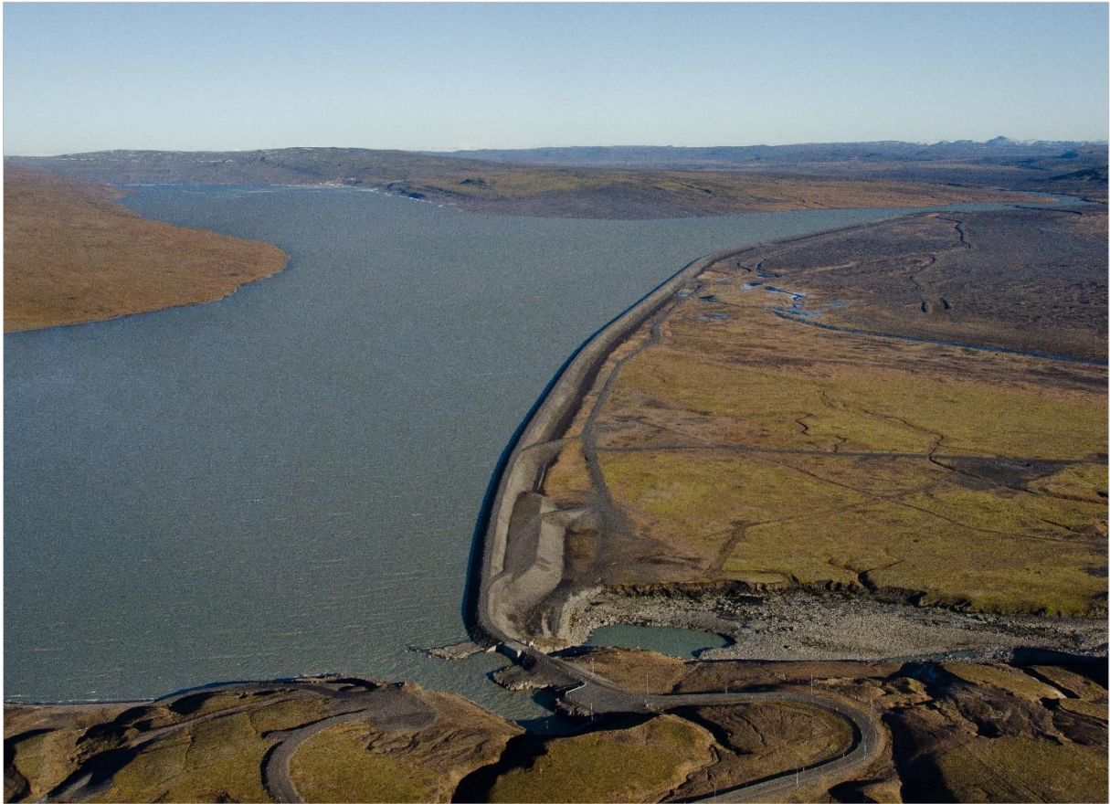
MYND 4. Horft til ANA yfir Sultartangalón og stíflu sem myndar það. Neðst á miðri mynd er botnrás og farvegur Þjórsár. (Mynd: Landsvirkjun).
