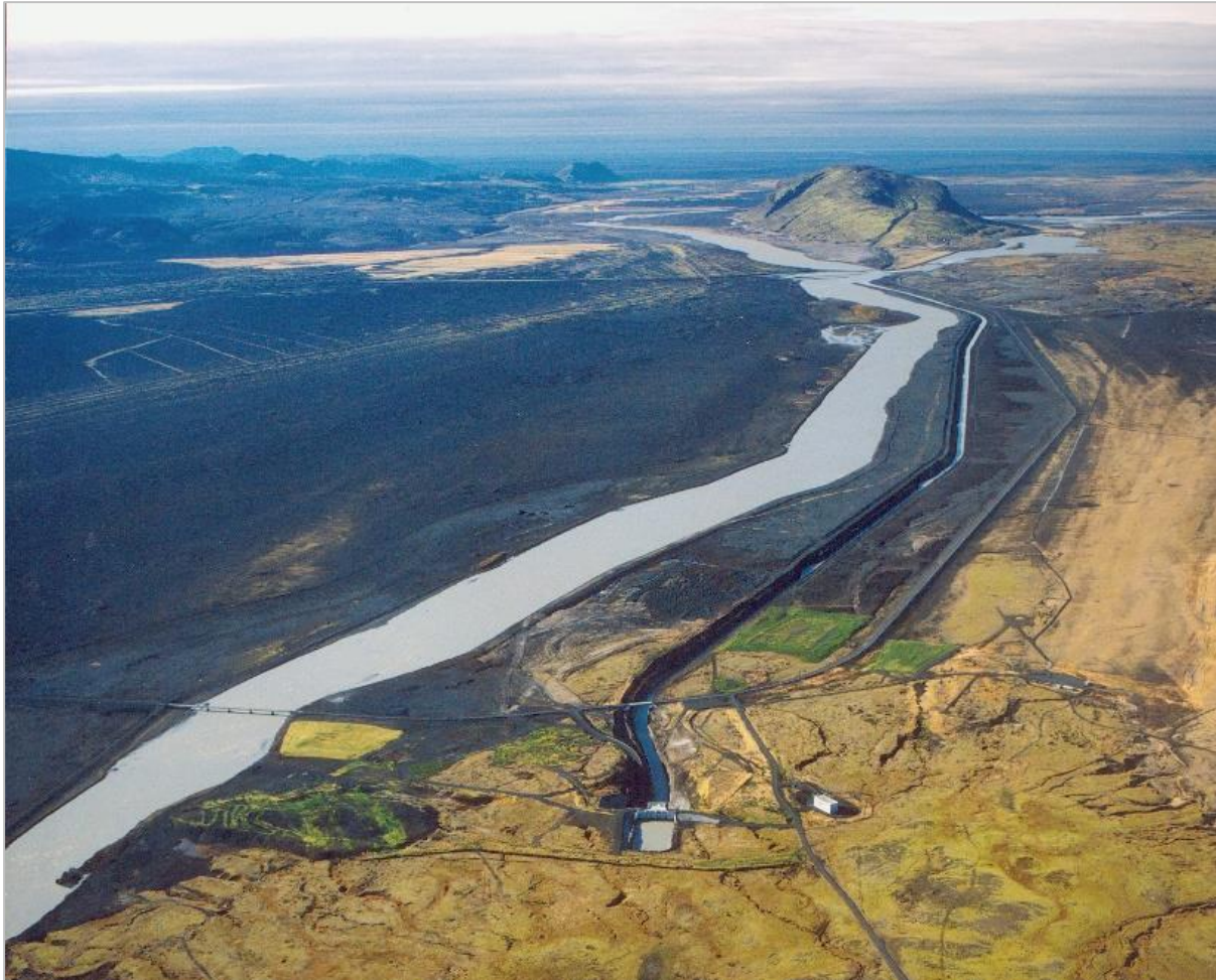
MYND 3. Stöðvarhús Sultartangastöðvar er neðst á miðri mynd. Þaðan liggur frárennisskurður samsíða Þjórsá. (Mynd: Landsvirkjun).
