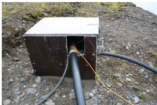
Mynd 5.4 – Lokuð dæla vatnslindar við Fjórðungskvísl, dælt upp í kaldavatnstank.
