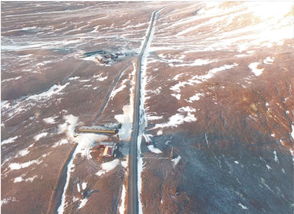
MYND 1. Horft til vesturs yfir núverandi mannvirki sunnan undir Geldingafelli. Geldingafell er hægra megin við Skálpanesveg.
